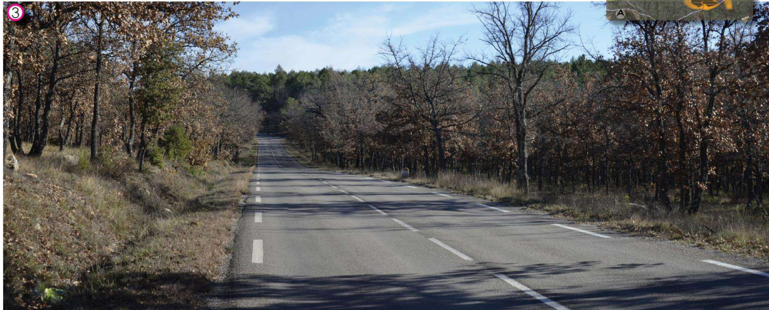
Depuis la RD 32 en direction de Sillans-la-Cascade avant le virage, cette perspective ouvre une vue axiale vers la partie nord de la zone de la centrale.
