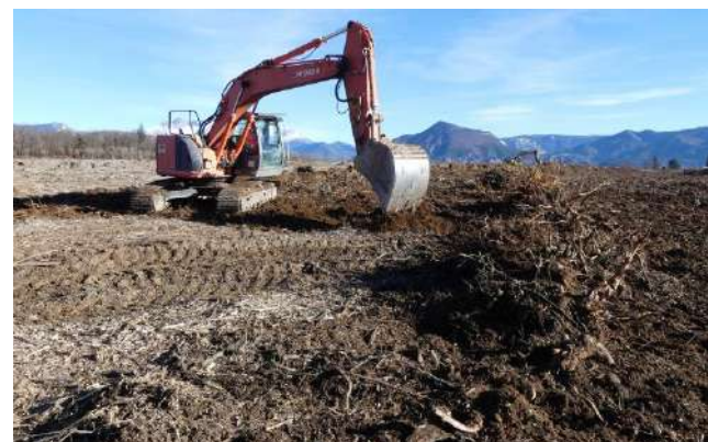
Retrait des souches par peignage superficiel du sol à l'aide de pelles mécaniques équipées de godets à dents. Puis andainage des souches extraites avant le broyage.
