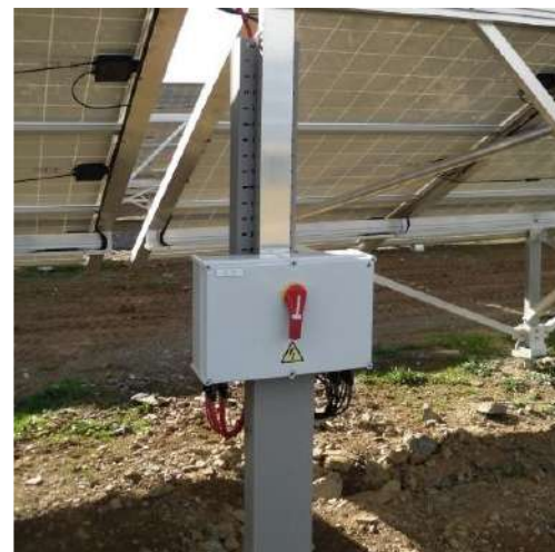
Photo 20. À gauche : câblage des panneaux – À droite : boîtier de raccordement
