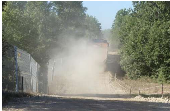
Exemple de levée de poussières lors du passage d'un camion : à éviter
