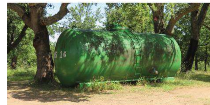
Intégration des citernes incendie
