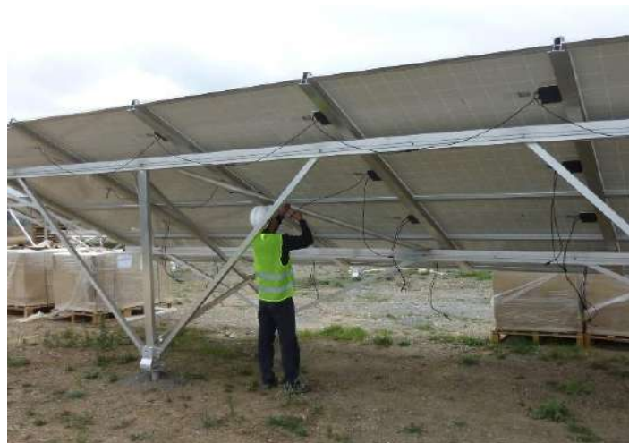
Photo 20. À gauche : câblage des panneaux – À droite : boîtier de raccordement
