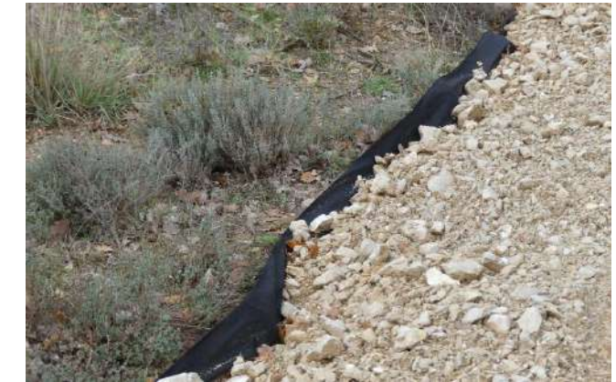
Géotextile placé sous une surface empierrée temporairement DRYOPTERIS, 2017
