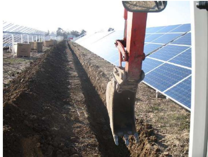
Photo 19. Exemple de tranchée entre deux tables photovoltaïques
