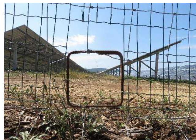
Trouées renforcées créées sur une clôture – DRYOPTERIS, 2018
