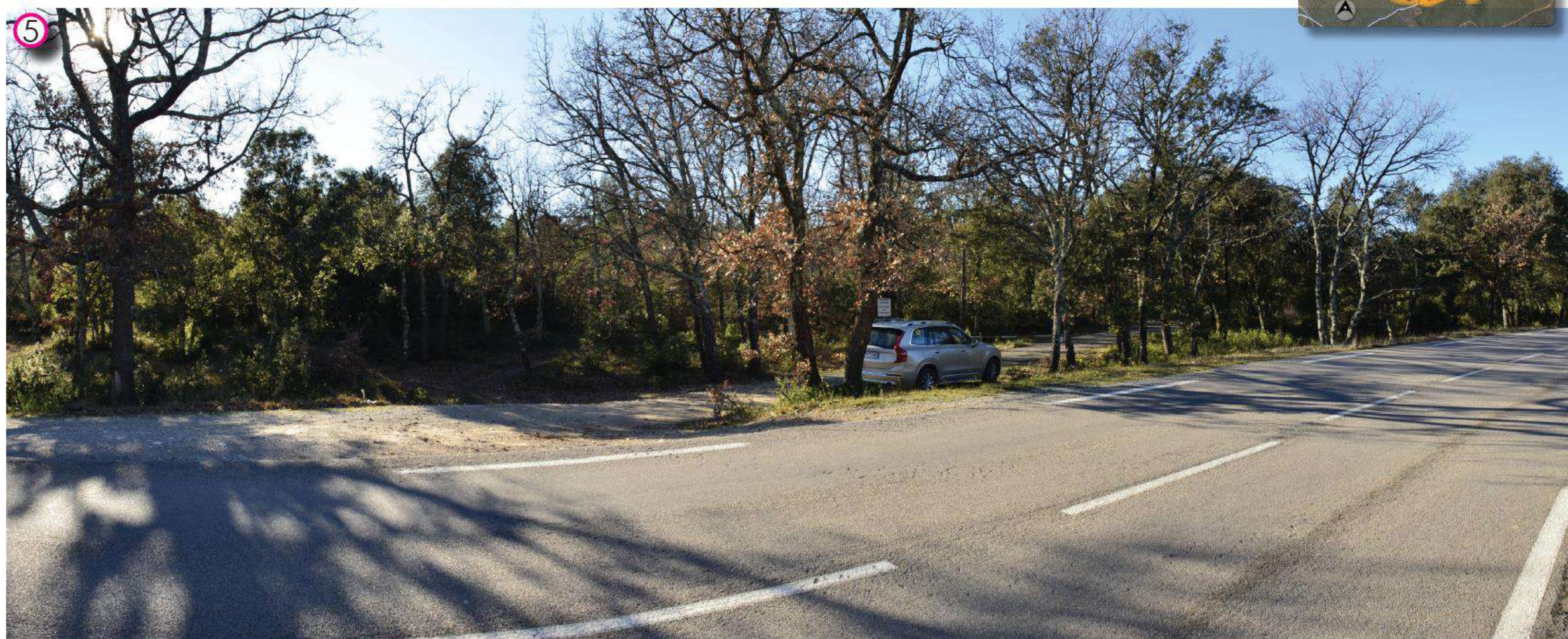
Depuis la RD 32 avant le virage la perspective ouvre une vue vers la partie nord de la zone de la centrale et son accès technique par la voie de l'ancien délaissé routier.
