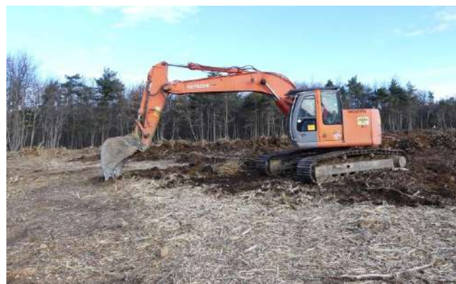
Retrait des souches par peignage superficiel du sol à l'aide de pelles mécaniques équipées de godets à dents. Puis andainage des souches extraites avant le broyage.
