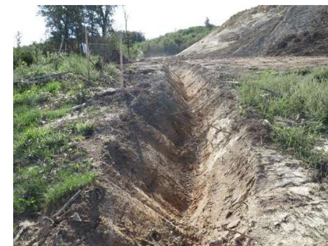
Exemple de fossés de récupération des eaux pluviales. ECOTER, 2016
